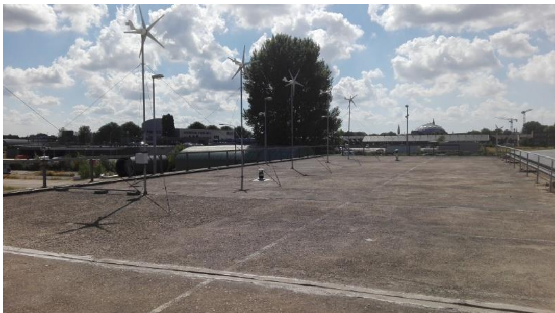
Zicht vanaf het dak in Zuidwestelijke richting. De hoge boom veroorzaakt windstiltes en turbulentie.
